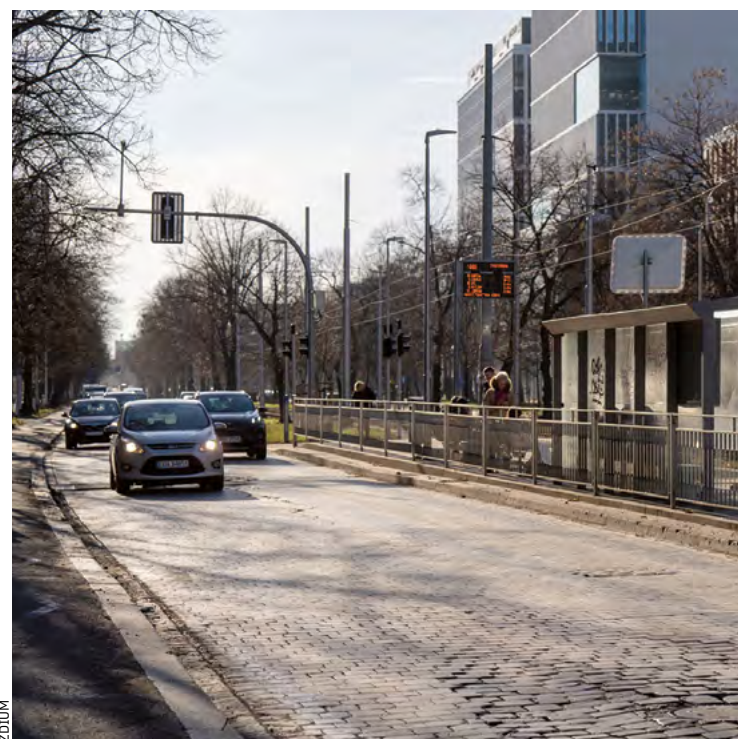
Po remoncie na Powstańców Śl. zamiast kostki ma być masa bitumiczna
