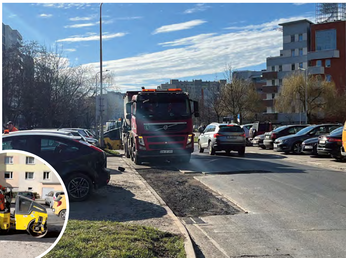
Trwa łatanie dziur na wrocławskich ulicach – każdy może zgłosić miejsce, które wymaga naprawy
